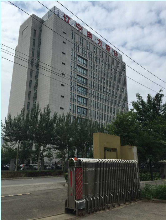
图 4 项目南侧辽宁电力设计院
