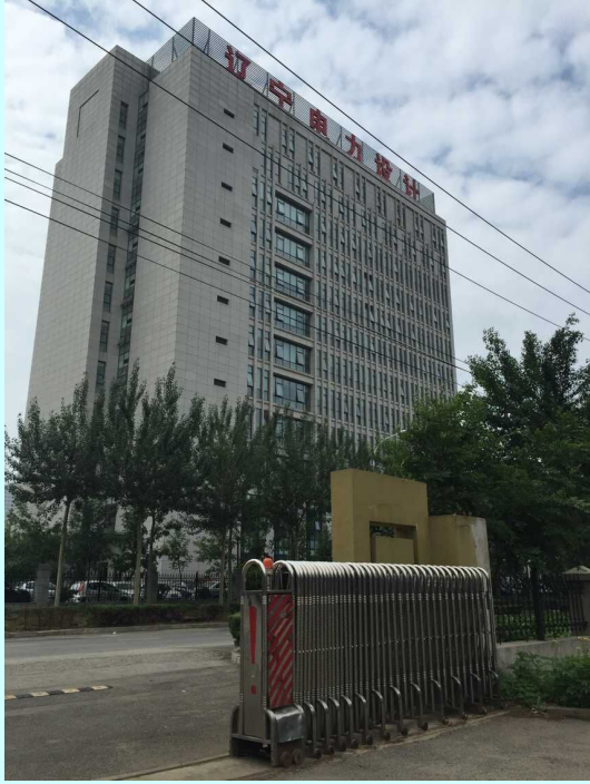
图 4 项目南侧辽宁电力设计院
