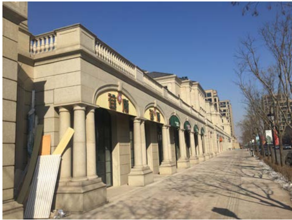
图3 项目北侧商业网点
