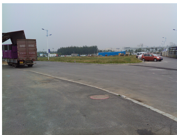
图 6 项目厂区北侧
