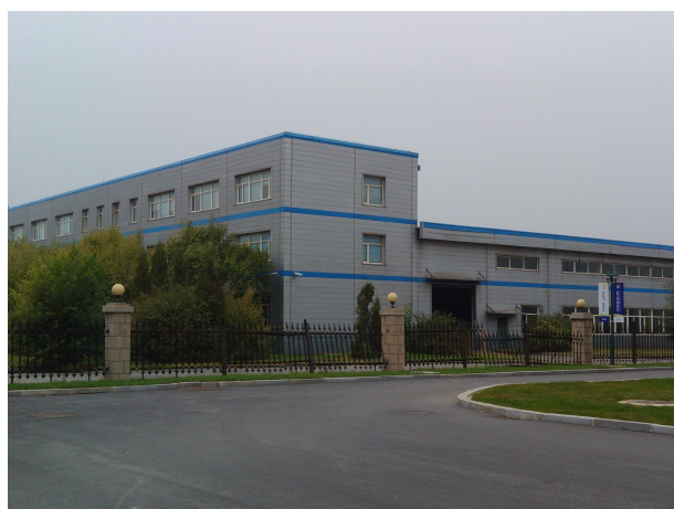
图 5 项目厂区西侧
